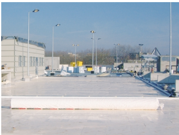
Extension de centre commercial Carrefour à Dijon
