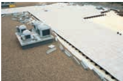
Hôpital de Nevers - Pose mixte : Protection meuble et dalles sur plot
